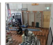
解体・撤去作業
